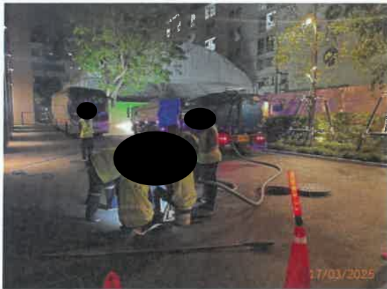
รูปที่ 16 การสูบน้ำส่วนเกินจากระบบบำบัด
