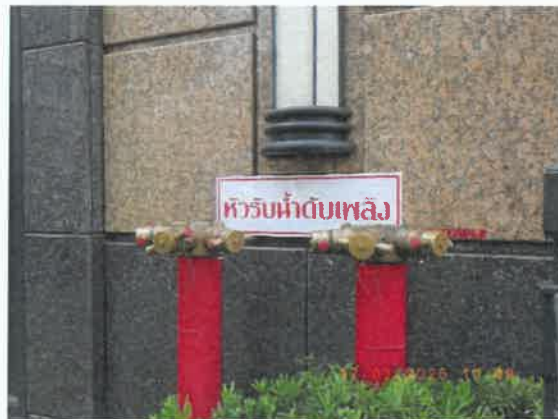
รูปที่ 54 หัวรับน้ำดับเพลิงภายนอกอาคาร
