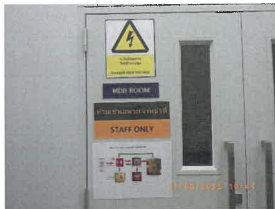
รูปที่ 47 ป้ายเตือนแสดงข้อความ “อันตรายไฟฟ้าแรงสูง” และ “เฉพาะเจ้าหน้าที่ที่เกี่ยวข้องเท่านั้น”
