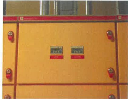
รูปที่ 15 ระบบมิเตอร์ไฟฟ้าสำหรับระบบบำบัด
