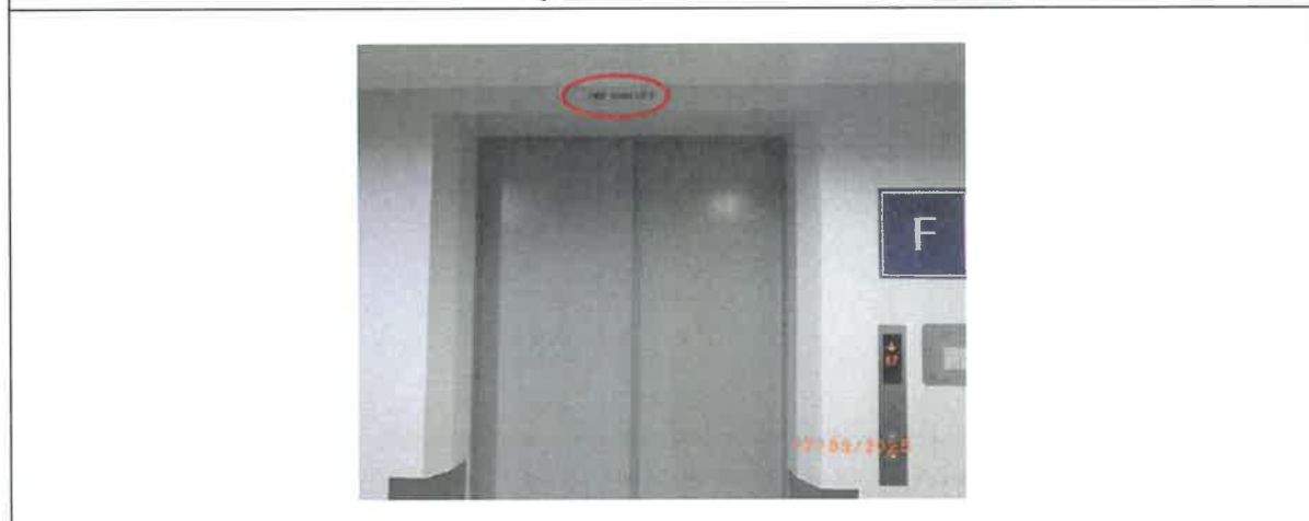
รูปที่ 58 ลิฟต์ดับเพลิง
